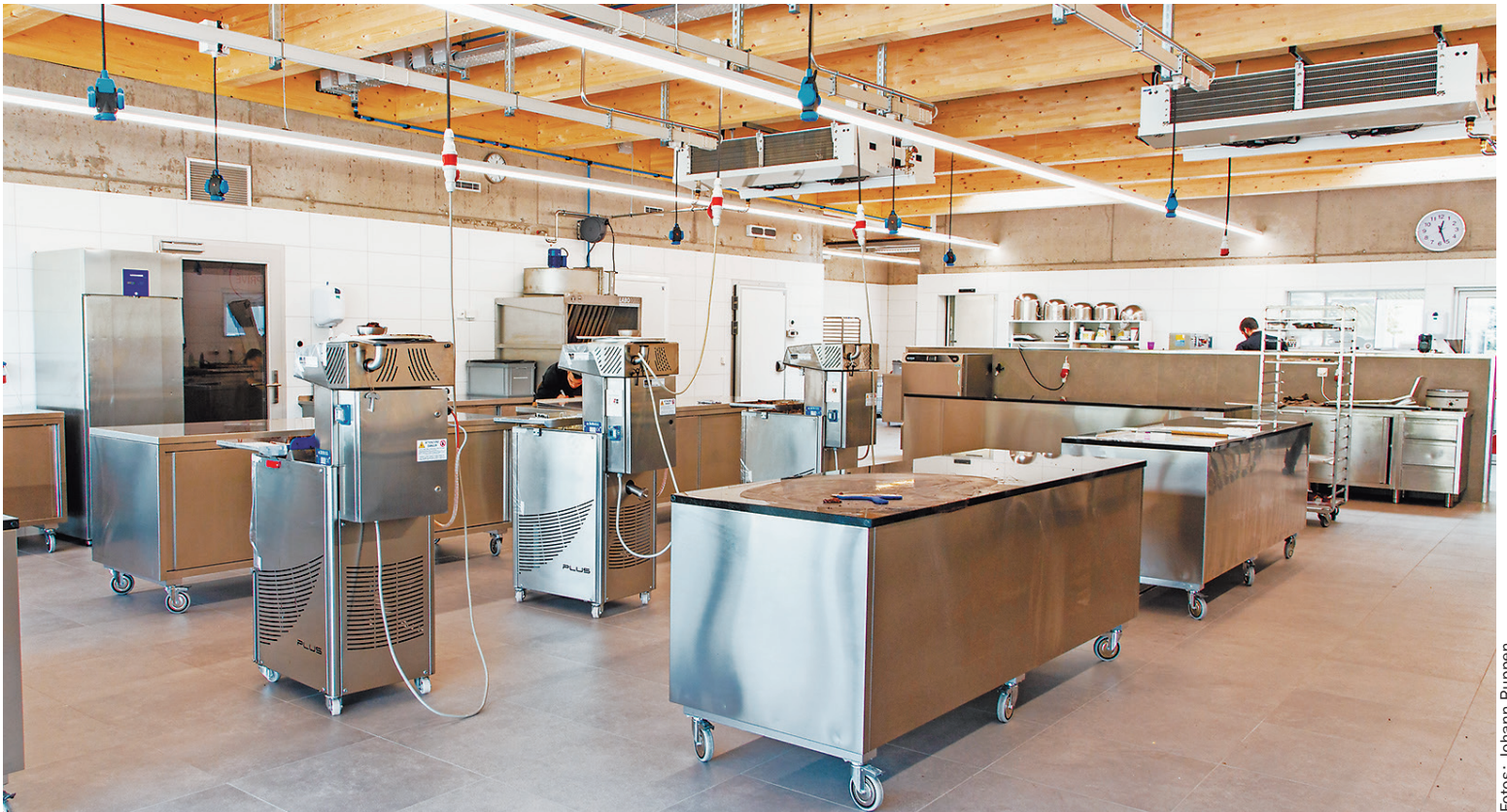
Die Produktionsräume und das gesamte Gebäude sind klimatisiert. Die Abwärme der Kälteanlagen wird zur Herstellung des Warmwassers genutzt.
