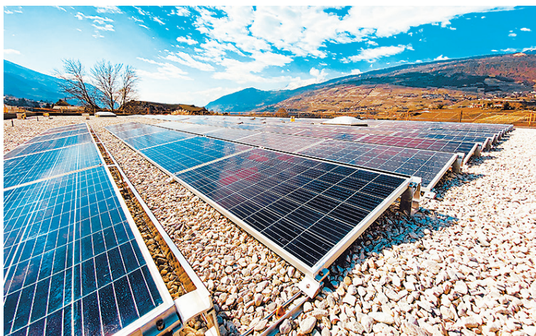
Avec 200 panneaux photovoltaïques sur le toit, le bâtiment produit en été 80 à 90 % de ses besoins en énergie.
